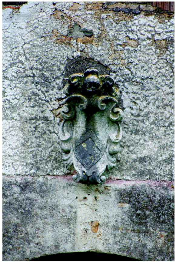
Fig. 13 - Lo stemma collocato sulla facciata dei magazzini settentrionali.
