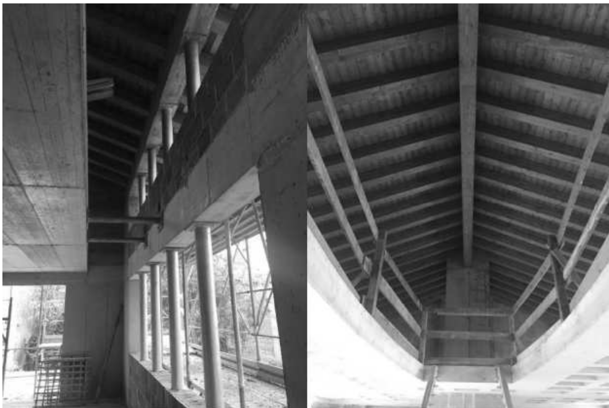
Vista solaio di copertura e passerella in cemento
