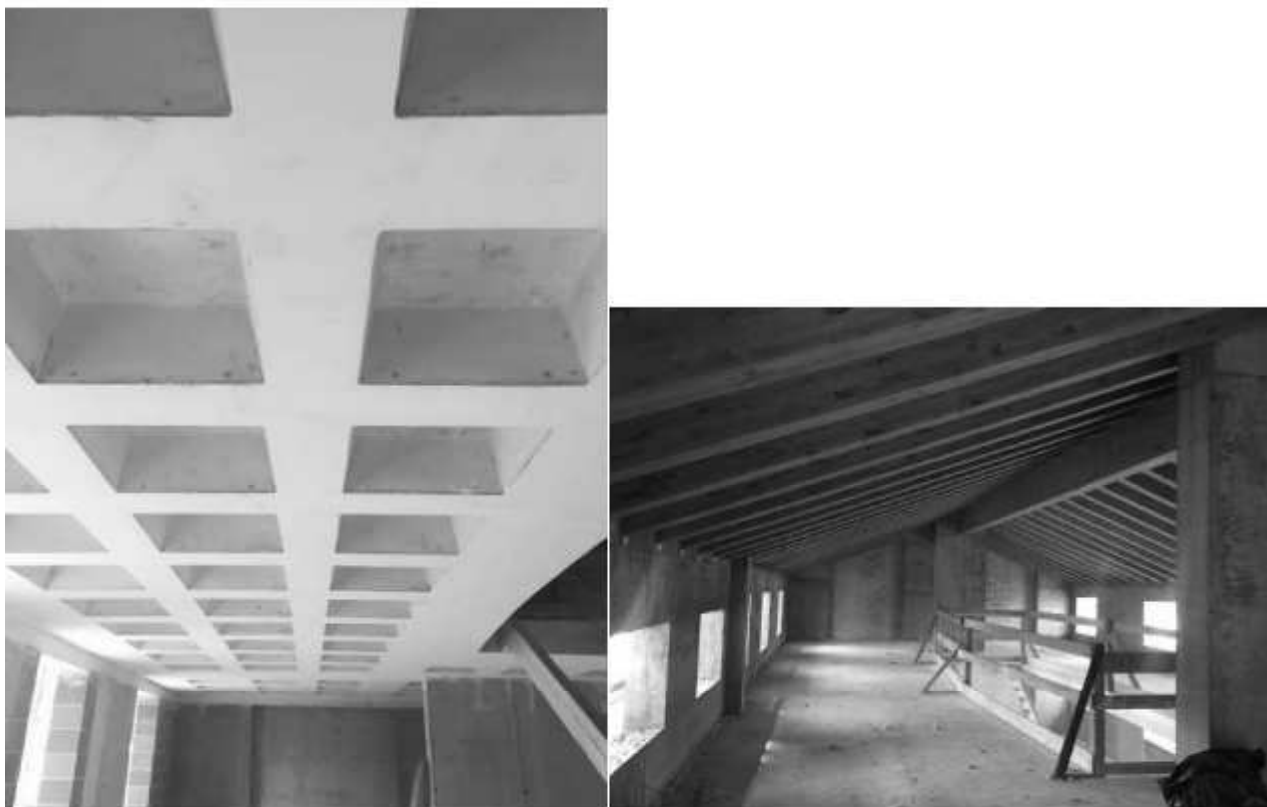
Vista solaio a cassettoni in cemento e solaio di copertura
