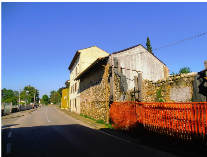
Fig. 4.0: Flambro, Via Spinucci – Edificio recentemente crollato
