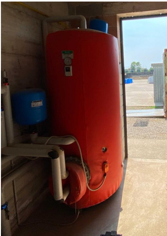
Accumulo termico esistente
