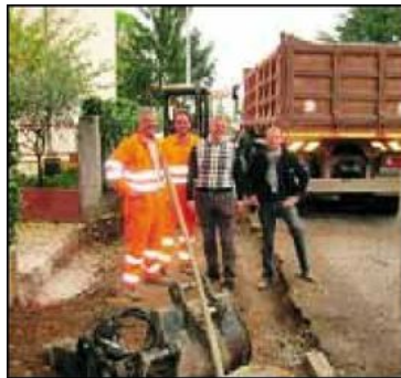
Il cantiere stradale
